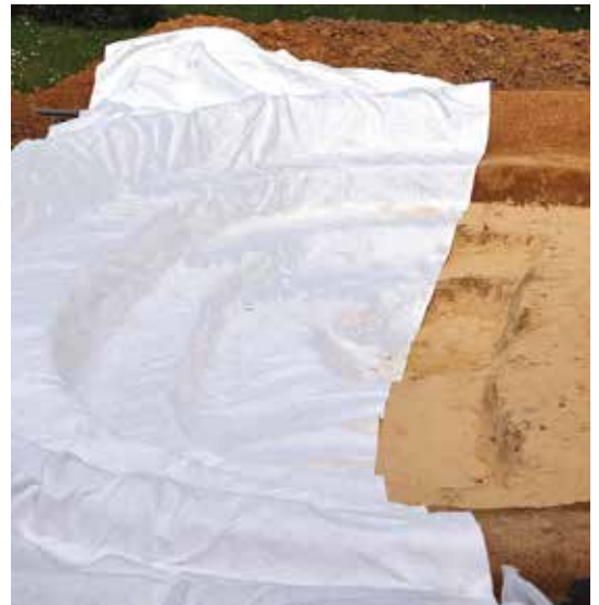
Aménagement d'un bassin
