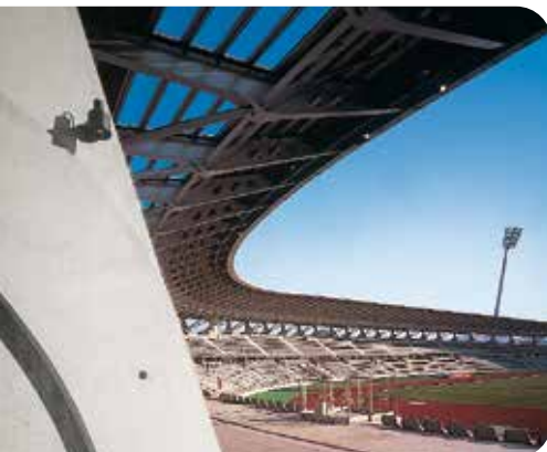
> Stade Charlety - Paris XIIIe : C55/67 Bureaux : C60/75 Architectes : Henri et Bruno Gaudin
