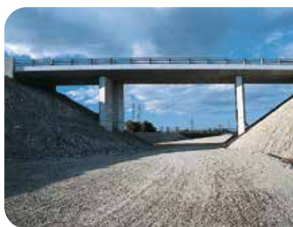
> TGV Méditerranée - Lot 13 : Tablier C80/95 Durabilité (résistance au gel et sels de déverglaçage)
