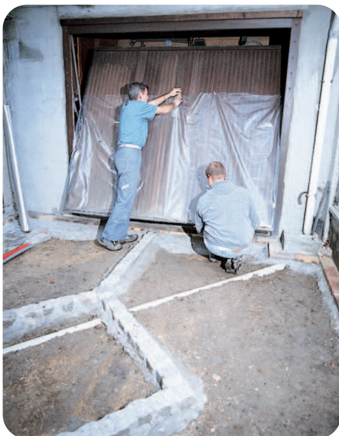
^ Mise en place du polyane de protection.
