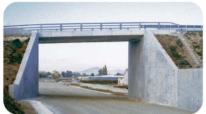
▲ Ouvrage d'art TGV Méditerranée
